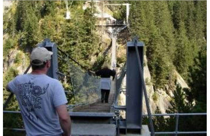
80m lang und 70m über Grund: Zugang zur Gelmerbahn
