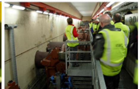
Blick in die „Schieberhalle“
