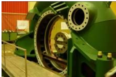
Blick in die Maschinenhalle „Grimsel 2“ wo gerade eine Turbine revidiert wurde.
