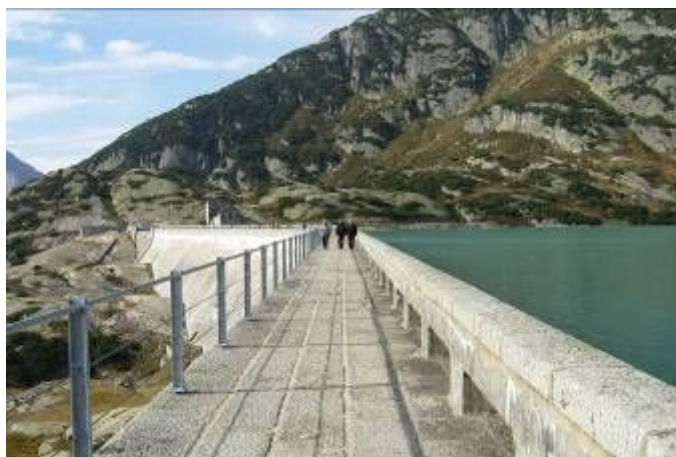
Staumauer des Gelmersees
